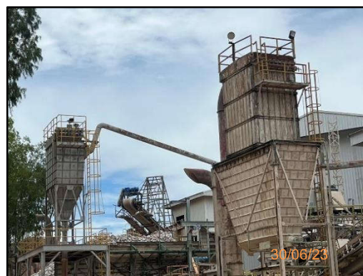
รูปที่ 2-18 ระบบป้องกันและกำจัดฝุ่น
